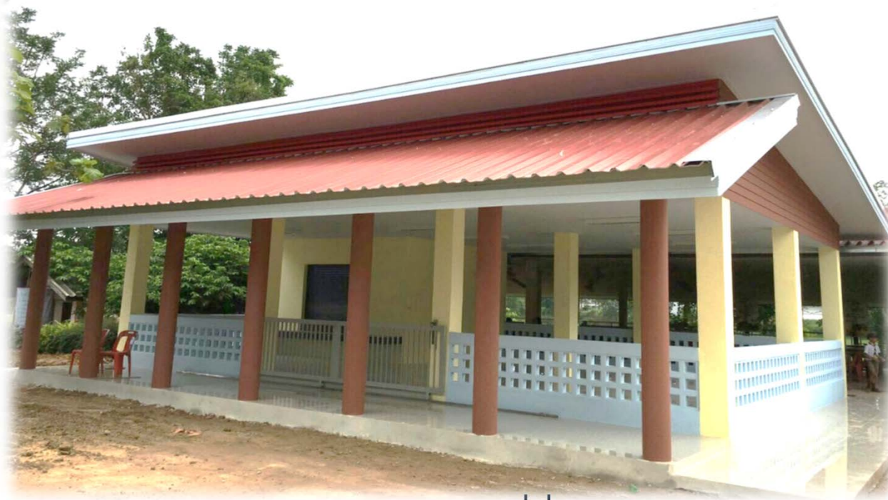
โรงอาหาร 84 ที่นั่ง โรงอาหาร 84 ที่นั่ง ในเขตแผ่นดินไหว กรอบอาคาร 12.70 x 14.00 เมตร สูง 4.55 เมตร พื้นที่ 150 ตรม.
