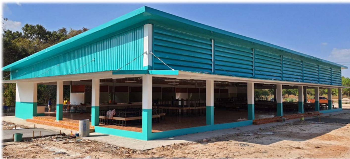
โรงอาหารขนาดกลาง 500 ที่นั่ง โรงอาหารขนาดกลาง 500 ที่นั่ง ในเขตแผ่นดินไหว ขนาดอาคาร 22.00 x 40.50 เมตร สูง 6.30 เมตร พื้นที่ 723 ตรม.
